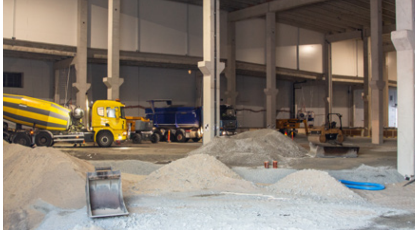
La obra de construcción de la planta de transmisiones ha empleado a una media de 20 personas, pero el número ha variado mucho en función de la fase de construcción.
